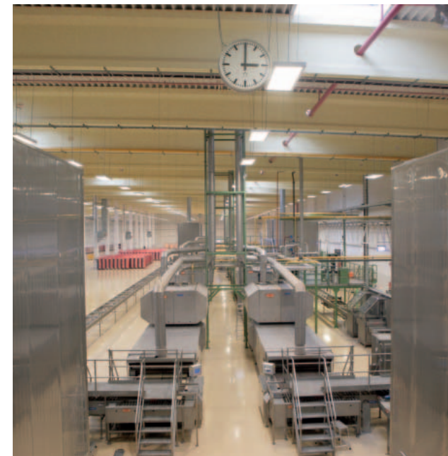
Die Produktionshalle im Werk Polch dokumentiert das hohe technologische Niveau
